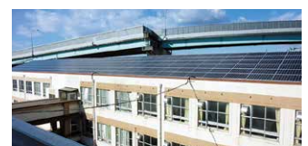
名古屋市立千音寺小学校 校舎屋上
