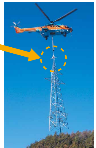
ヘリによる鉄塔の運搬状況
