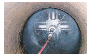
超高压水によるプラストの状況
