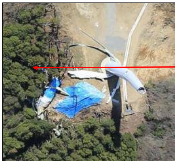
写真 2 ブレード・ナセル脱落方向と事故時の風向
