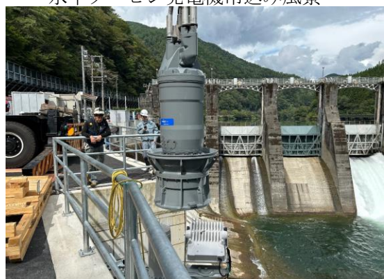
水中タービン発電機吊込み風景
