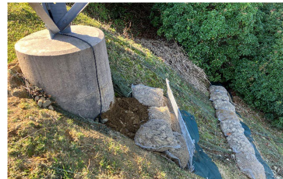
流速低減・表土流出防止 (ステンレス土嚢+地中シガラ)
