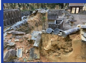
豪雨による土砂流出等で壁が破損
