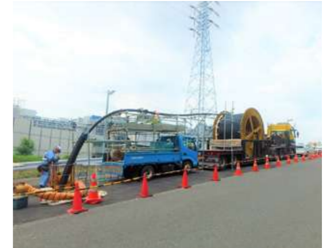
■ ケーブル布設工事
