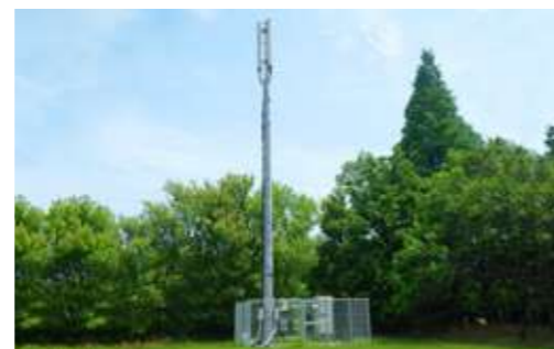
■ モバイル基地局建設・無線鉄塔工事
