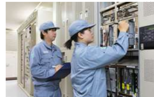
■ 多重無線設備の点検・保守
