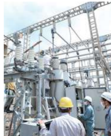
■ 変電所設備点検
