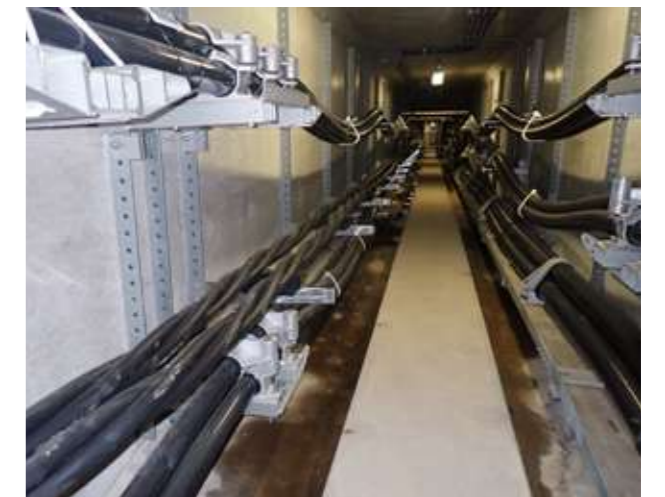
■ 洞道ケーブル布設状況
