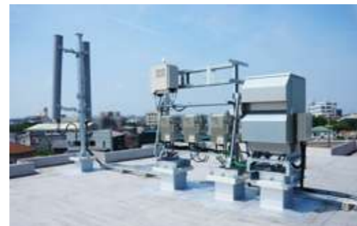
■ モバイル基地局建設工事(ビル屋上)
