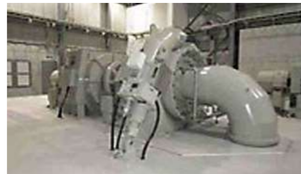
■ 二股発電所改修工事
