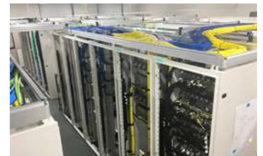
■ CATVセンター設備設置工事
