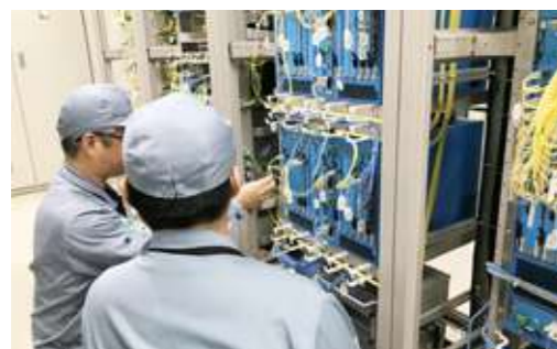
■ 通信伝送装置の取付工事
