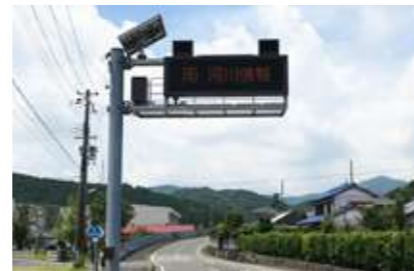
■ 道路情報板工事
