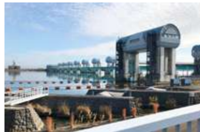
■ 河口堰監視カメラ工事
