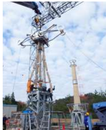
■ 500kV 断路器組立工事
