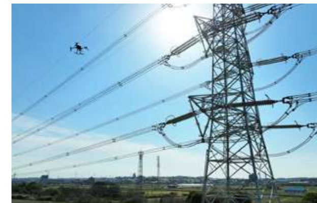
■ 架空送電設備の点検
