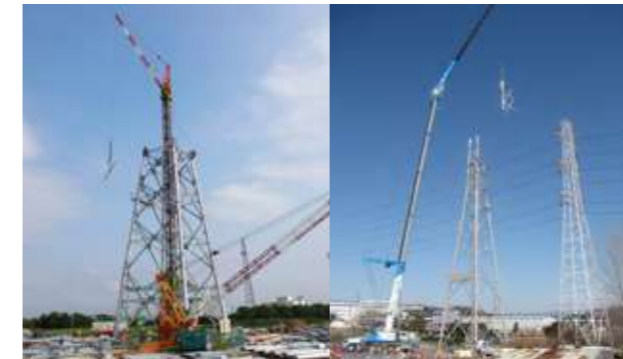
■ 架空送電設備の新設・改修工事
