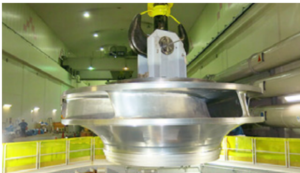
■ 奥美濃発電所水車発電機細密点検
