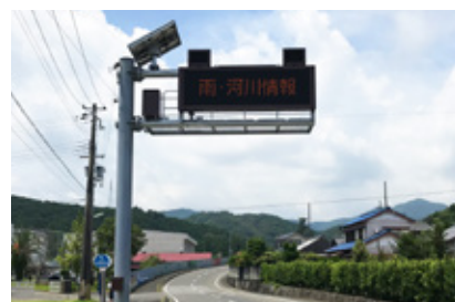
■ 道路情報板工事
