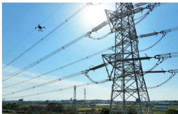
■ 架空送電設備の点検
