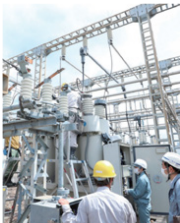
■ 変電所設備点検
