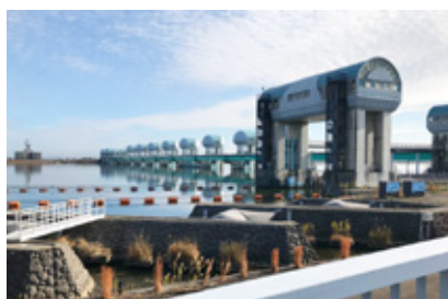
■ 河口堰監視カメラ工事
