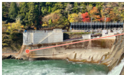
■ 中切水力発電所
