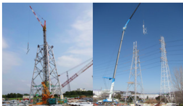
■ 架空送電設備の新設・改修工事
