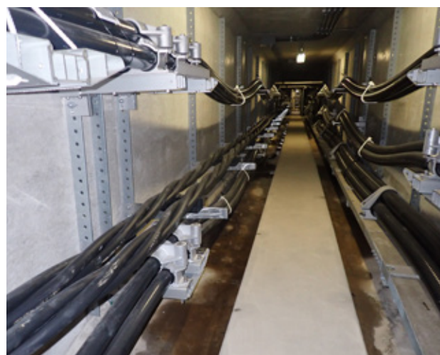
■ 洞道ケーブル布設状況
