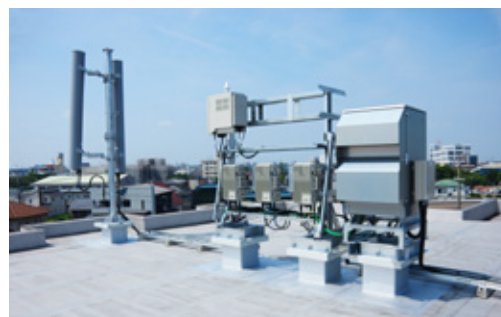
■ モバイル基地局建設工事(ビル屋上)
