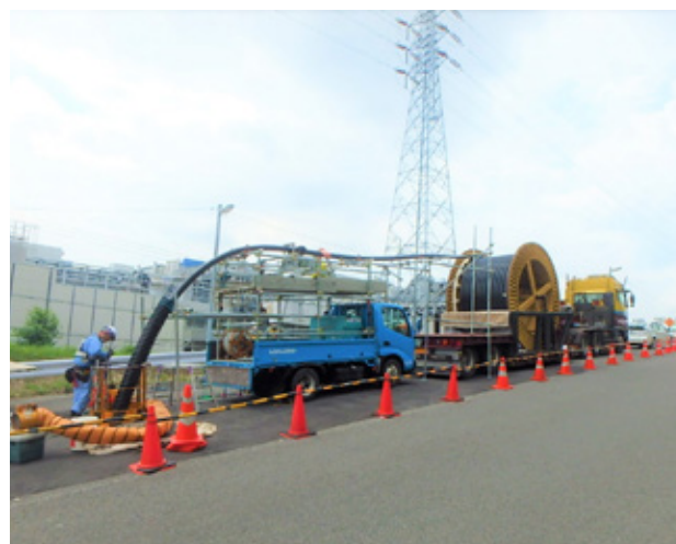
■ ケーブル布設工事
