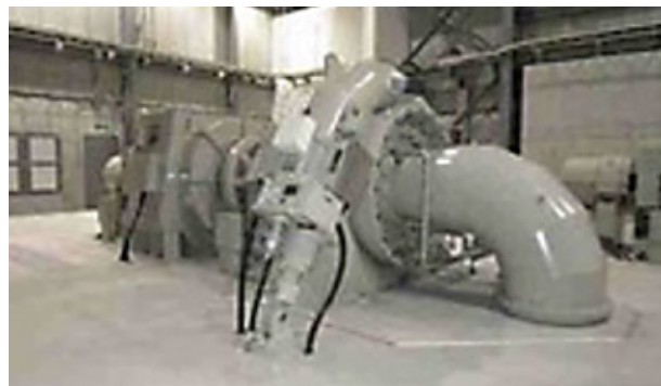
■ 二股発電所改修工事
