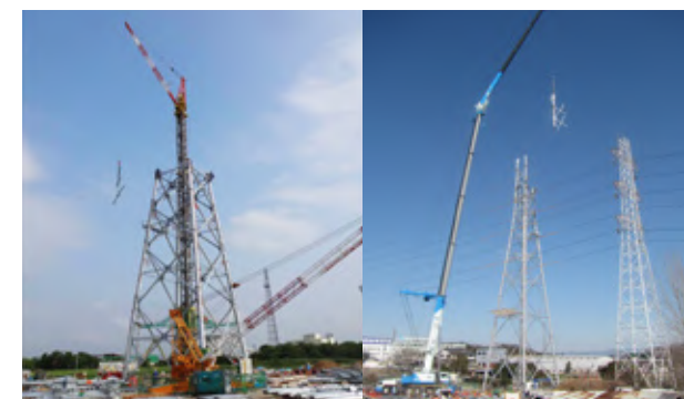
■ 架空送電設備の新設・改修工事
