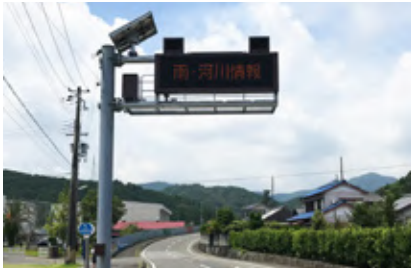
道路情報板工事
