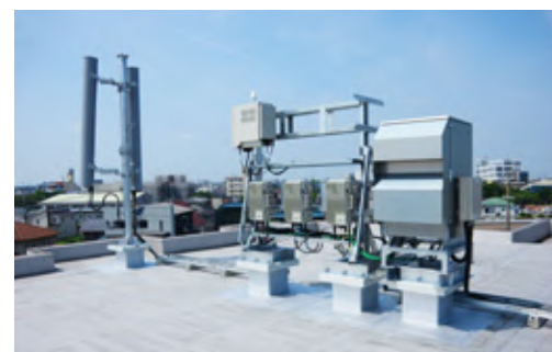
■ モバイル基地局建設工事(ビル屋上)
