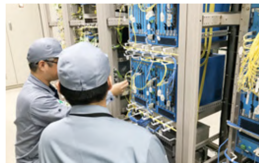
■ 通信伝送装置の取付工事
