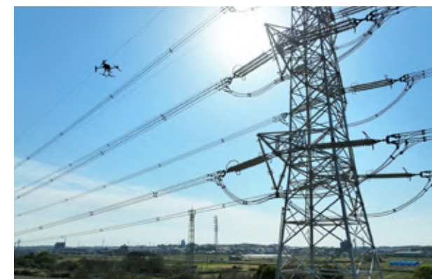
■ 架空送電設備の点検
