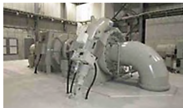
■ 二股発電所改修工事
