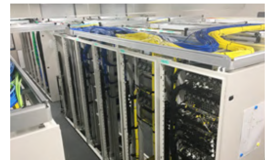
■ CATVセンター設備設置工事
