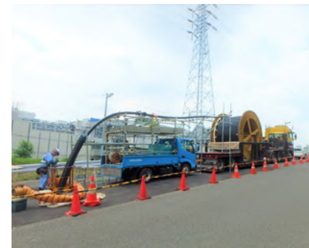
■ ケーブル布設工事
