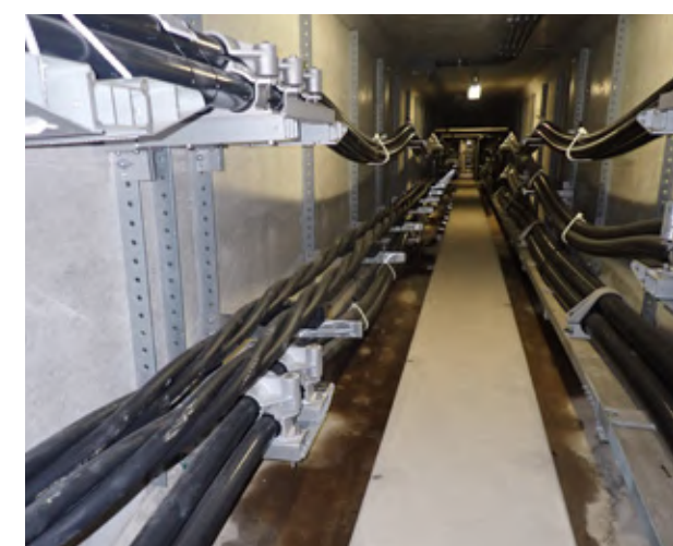
■ 洞道ケーブル布設状況
