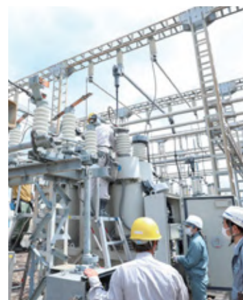
■ 変電所設備点検
