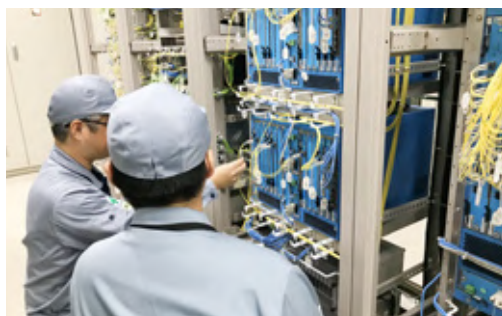
■ 通信伝送装置の取付工事
