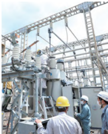
■ 変電所設備点検
