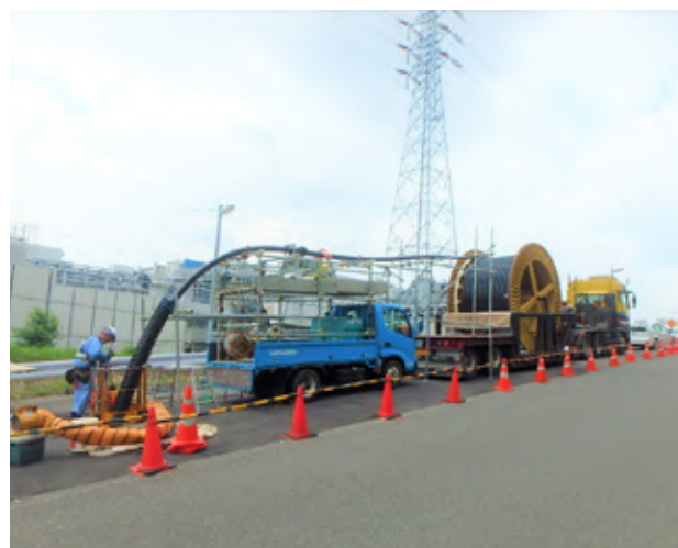
■ ケーブル布設工事
