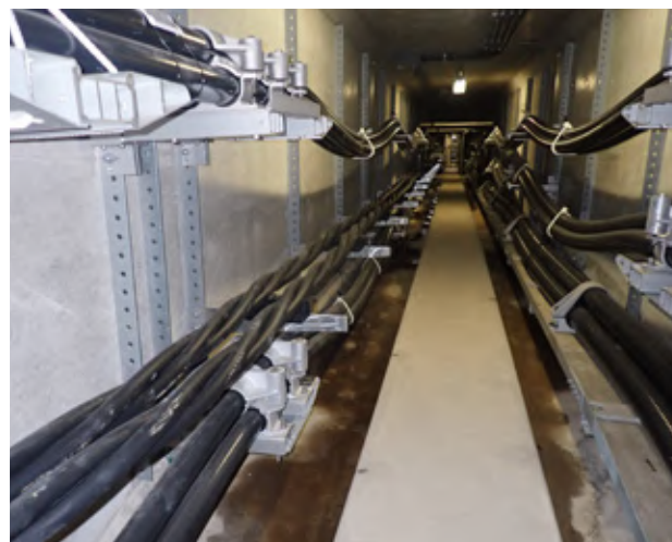
■ 洞道ケーブル布設状況
