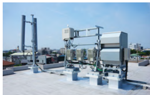
■ モバイル基地局建設工事(ビル屋上)
