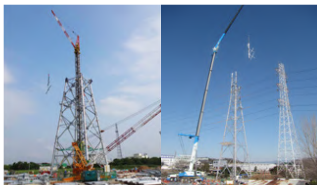
■ 架空送電設備の新設・改修工事
