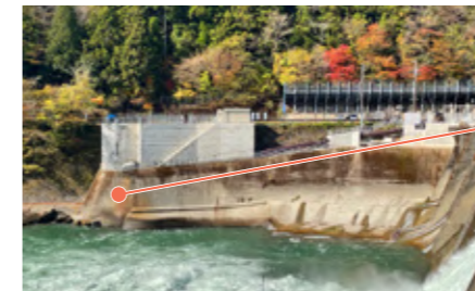
■ 中切水力発電所
