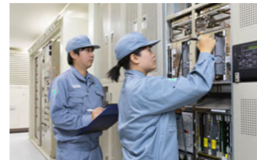
■ 多重無線設備の点検・保守
