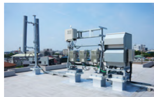
■ モバイル基地局建設工事(ビル屋上)
