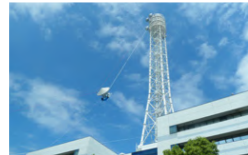
■ パラボラアンテナ設置工事(ガイドワイヤー工法)
