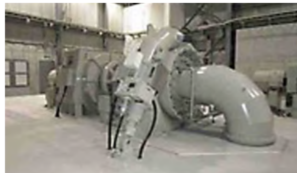
■ 二股発電所改修工事
