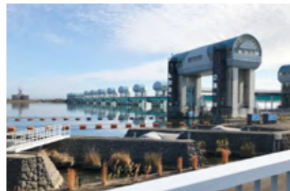
■ 河口堰監視カメラ工事
