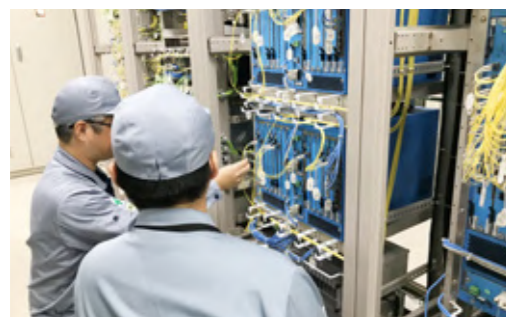
■ 通信伝送装置の取付工事
