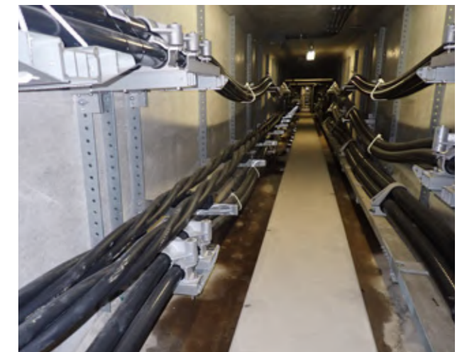
■ 洞道ケーブル布設状況
