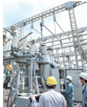
■ 変電所設備点検
