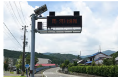
■ 道路情報板工事
