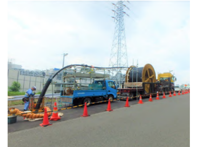
■ ケーブル布設工事
