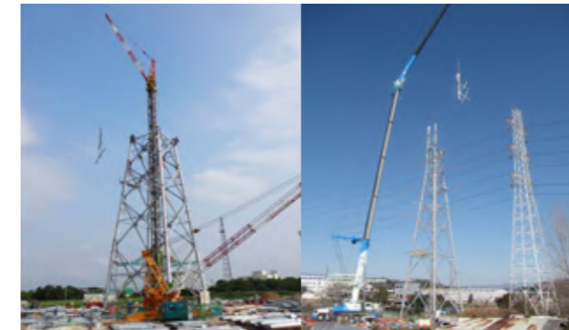
■ 架空送電設備の新設・改修工事
