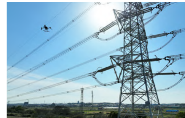
■ 架空送電設備の点検
