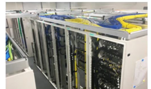
■ CATVセンター設備設置工事
