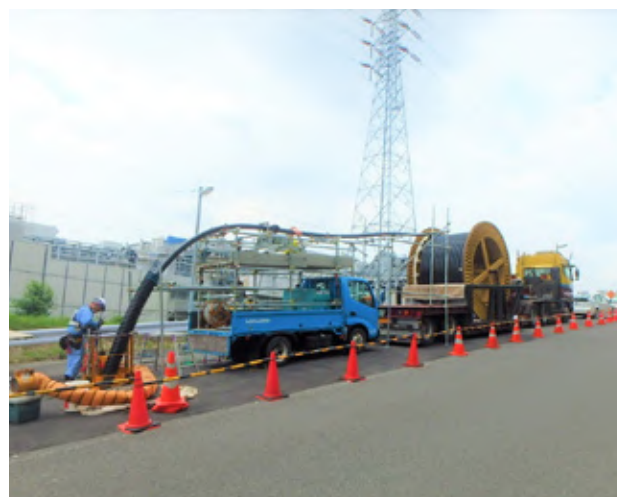
■ ケーブル布設工事
