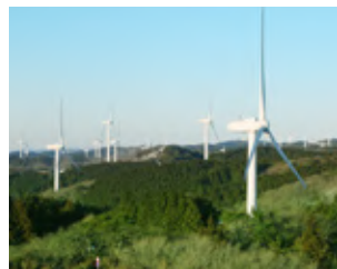
■ 新青山高原風力発電所 (横青山高原ウインドファームが運営)
