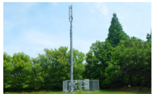
■ モバイル基地局建設・無線鉄塔工事
