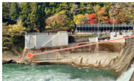
■ 中切水力発電所
