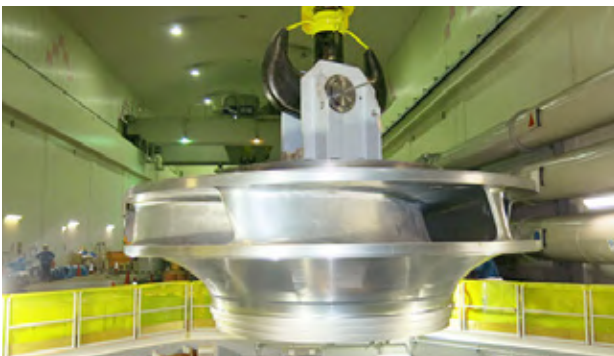
■ 奥美濃発電所水車発電機細密点検
