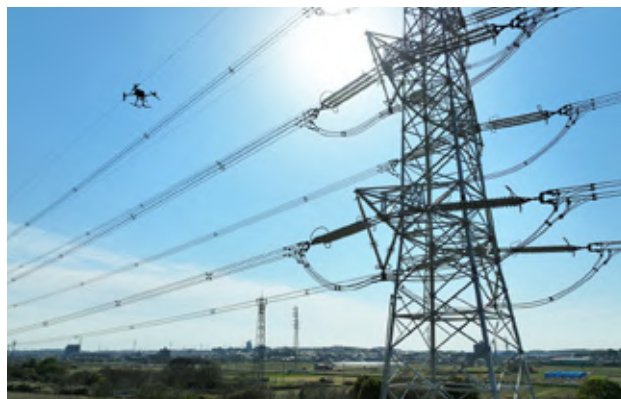
■ 架空送電設備の点検
