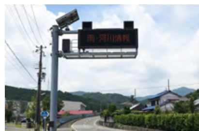
■ 道路情報板工事
