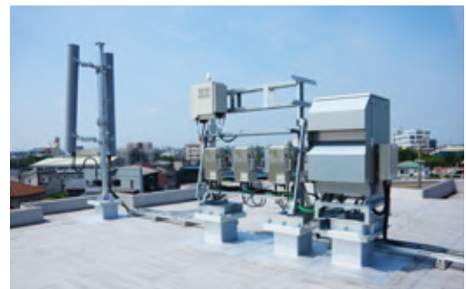
■ モバイル基地局建設工事(ビル屋上)
