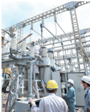
■ 変電所設備点検
