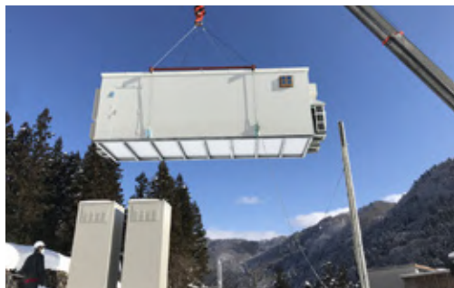
■ 5Gネットワーク用中継局舎建設工事
