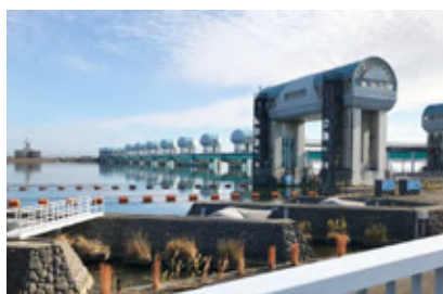
■ 河口堰監視カメラ工事
