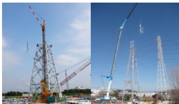
■ 架空送電設備の新設・改修工事
