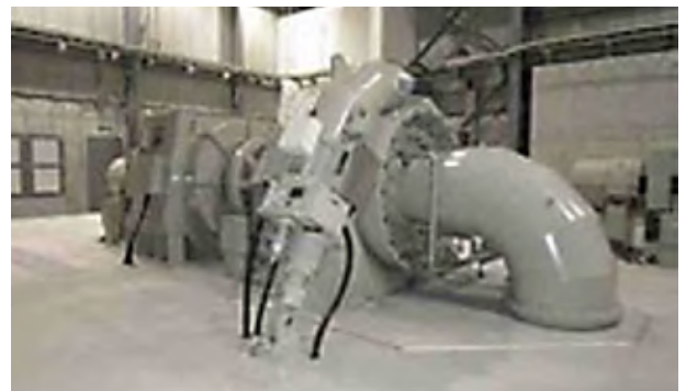
■ 二股発電所改修工事
