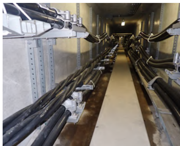
■ 洞道ケーブル布設状況
