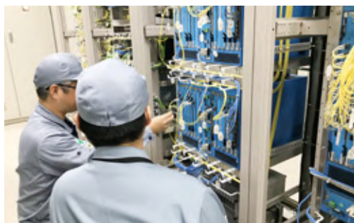
■ 通信伝送装置の取付工事
