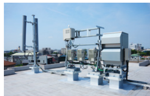
■ モバイル基地局建設工事(ビル屋上)
