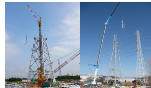
■ 架空送電設備の新設・改修工事
