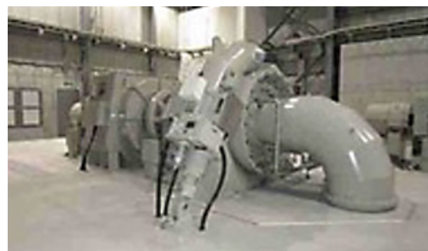
■ 二股発電所改修工事
