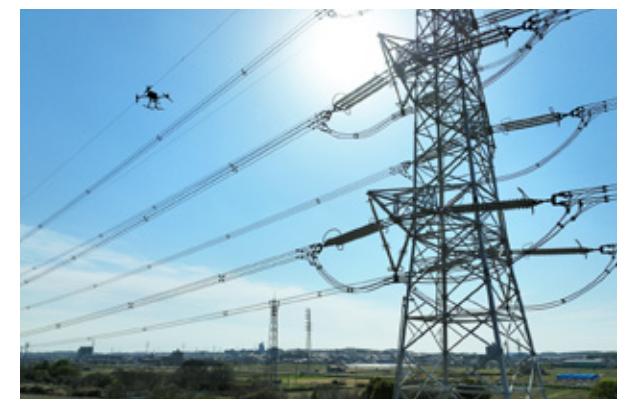
■ 架空送電設備の点検
