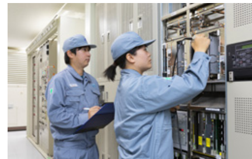
■ 多重無線設備の点検・保守
