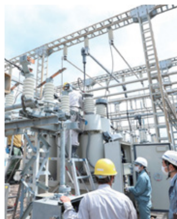
■ 変電所設備点検
