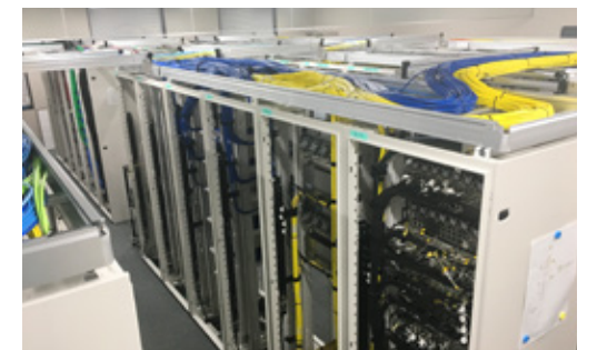
■ CATVセンター設備設置工事
