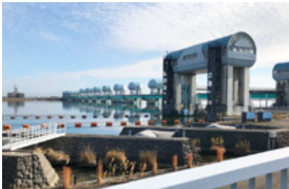
河口堰監視カメラ工事
