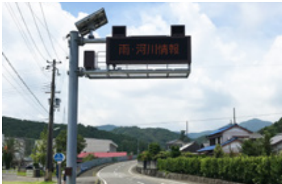
道路情報板工事
