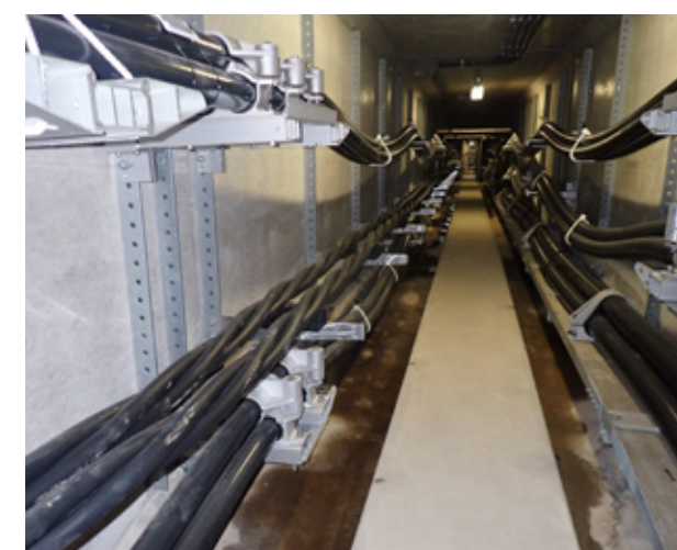
■ 洞道ケーブル布設状況
