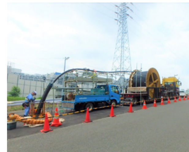
■ ケーブル布設工事
