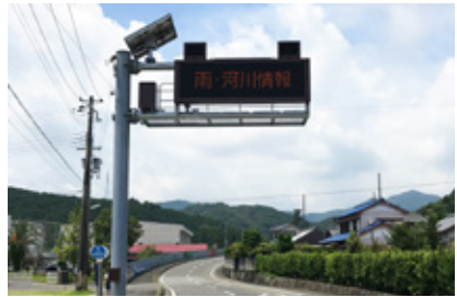
■ 道路情報板工事
