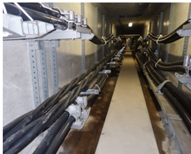
■ 洞道ケーブル布設状況
