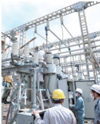
■ 変電所設備点検
