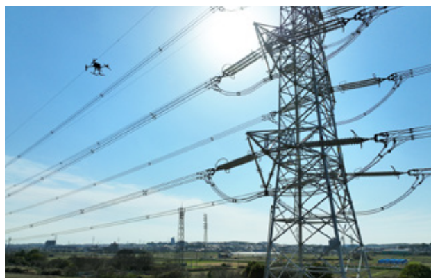
■ 架空送電設備の点検
