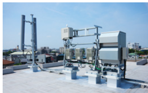
■ モバイル基地局建設工事(ビル屋上)
