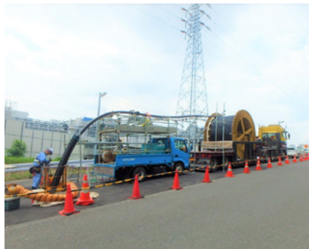
■ ケーブル布設工事
