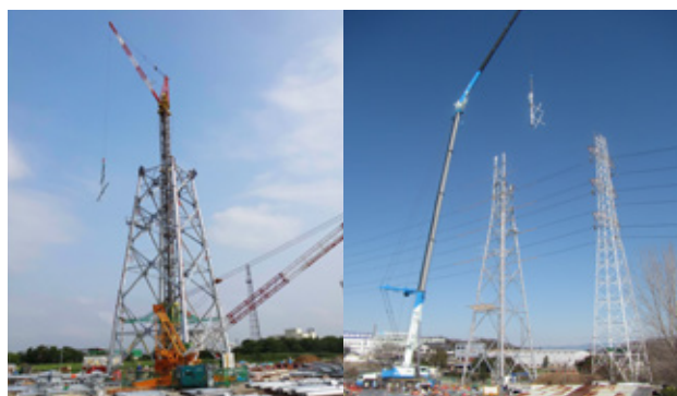
■ 架空送電設備の新設・改修工事
