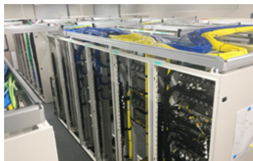
■ CATVセンター設備設置工事
