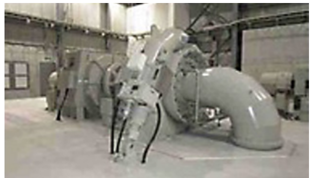
■ 二股発電所改修工事
