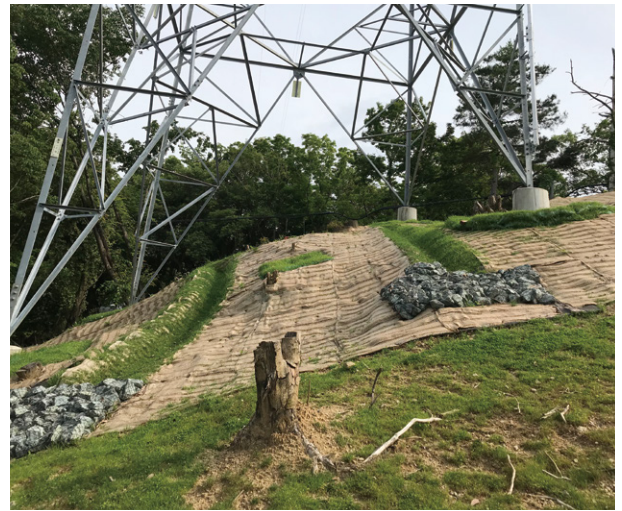
小土木技術を活用した現場施工例
