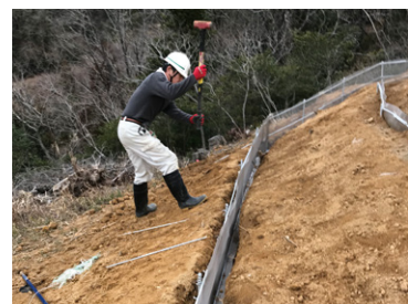
鋼製シガラ設置状況
