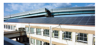
名古屋市立千音寺小学校 校舎屋上
