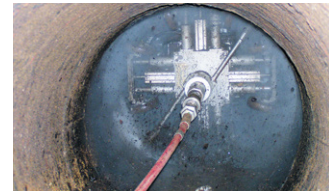
超高压水によるプラストの状況
