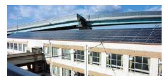
名古屋市立千音寺小学校 校舎屋上
