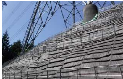
雨水誘導マットによる表層土砂流出対策
