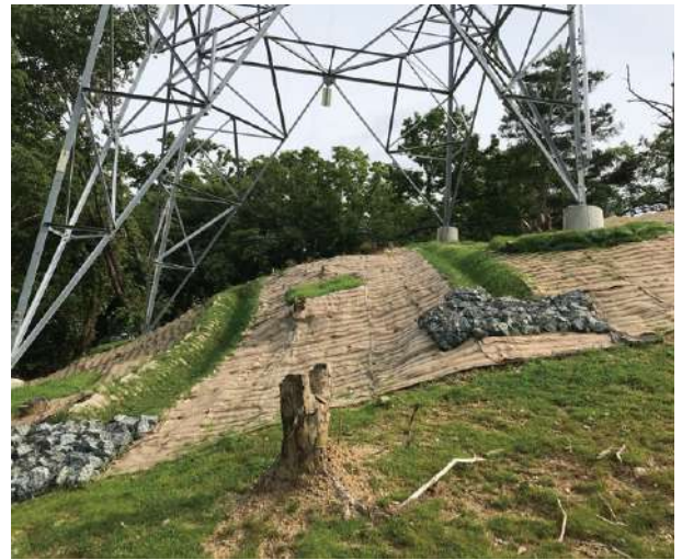
小土木技術を活用した現場施工例
