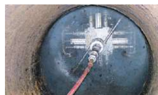
超高压水によるプラストの状況
