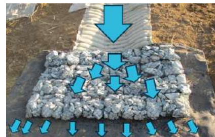
ストーンバッグによる流末処理
