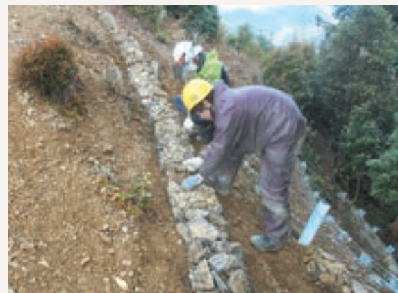
ストーンバッグ施工の様子
