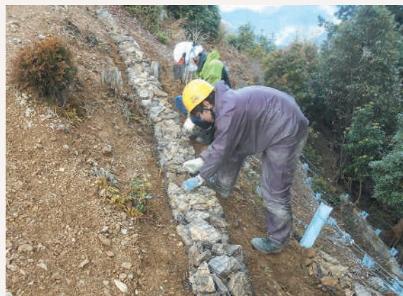
ストーンバッグ施工の様子
